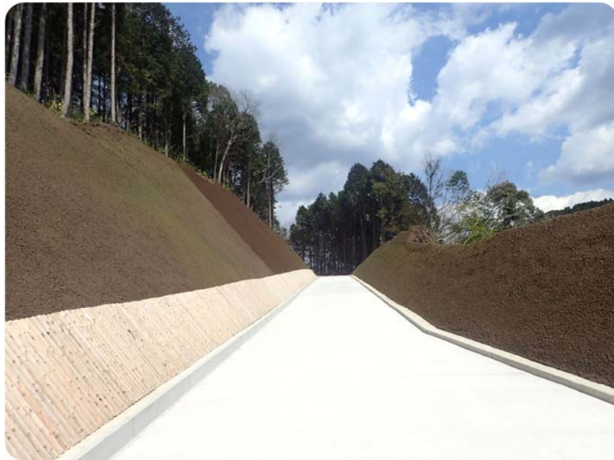
第34回民有林林道工事コンクール 林野庁長官賞 志布志市 御在所岳線6工区（森林管理道開設）
