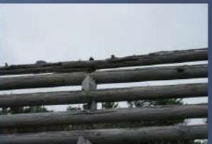
H18施工箇所（最上部丸棒の腐朽）
