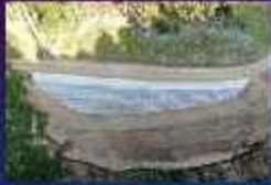
アンカー式ブロック積工
