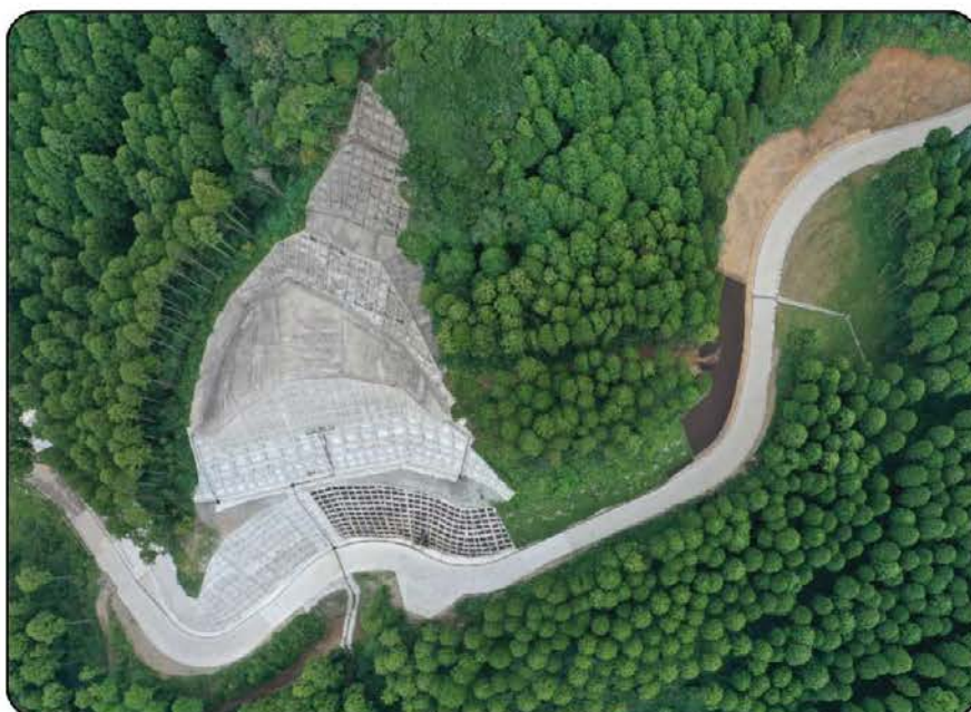
第 39 回民有林林道工事コンクール 日本林道協会会長賞 鹿児島市 森林管理道開設 横見谷線 1 工区 (山村強靱化林道整備事業)
